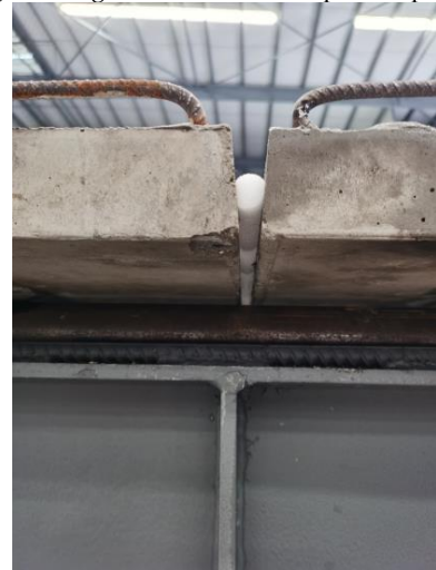
(d) Placing a PE rod
